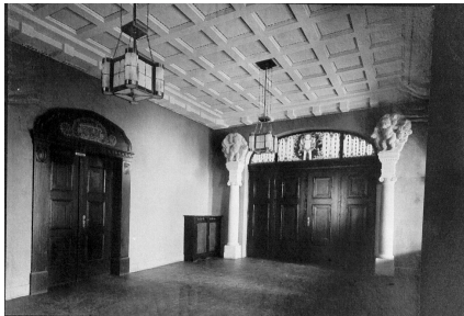
Aulaeingang im Altbau
